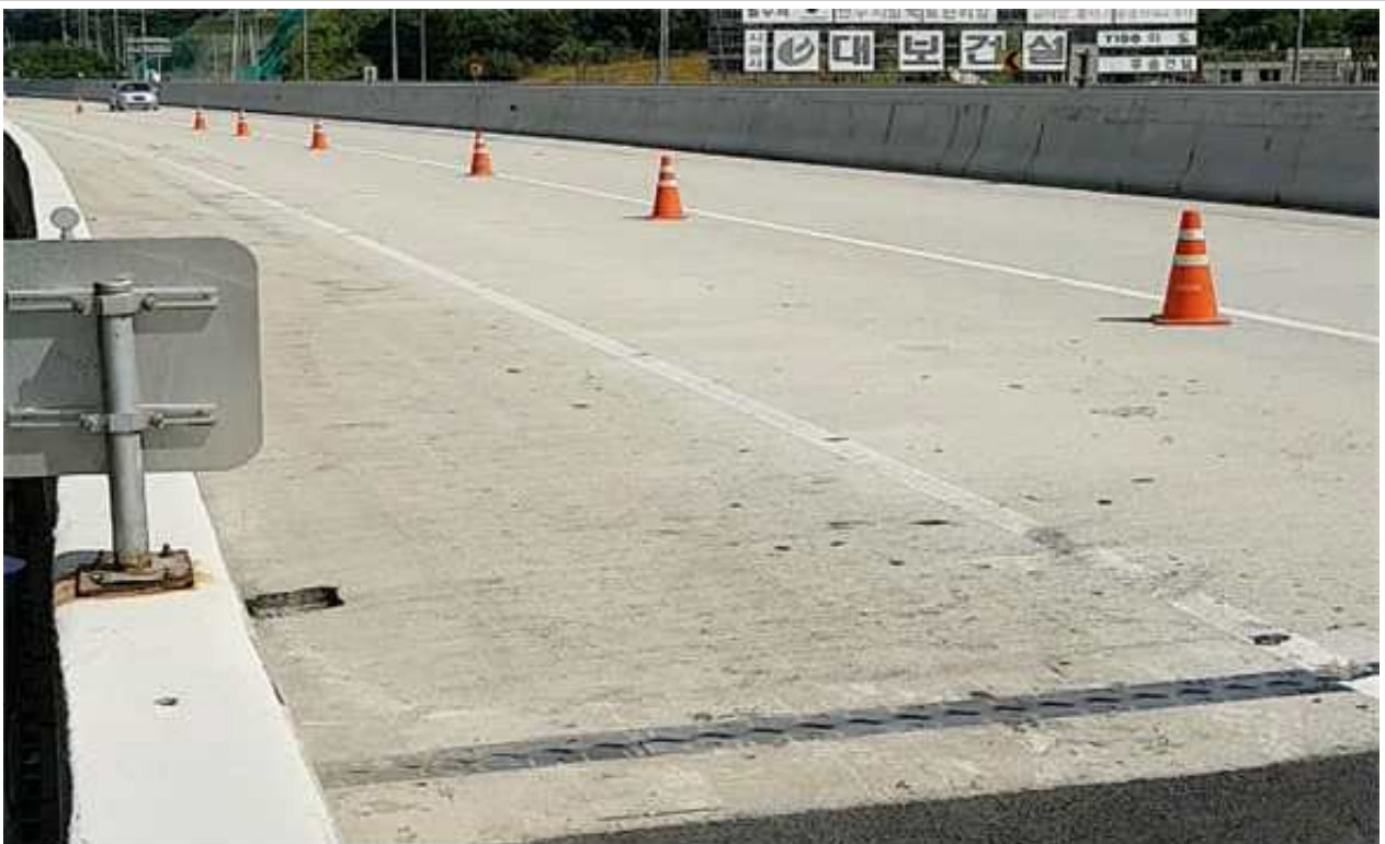
교량 상부 전경
